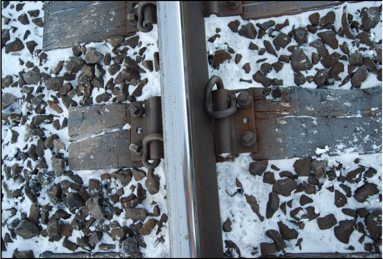
Photo 4. Système de fixation à selles laminées
