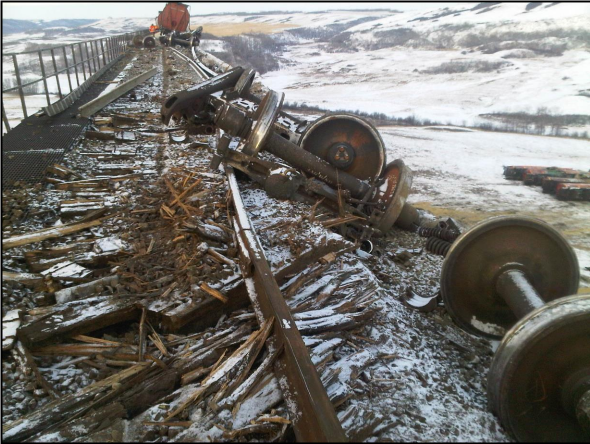
Photo 3. Extrémité est du pont
