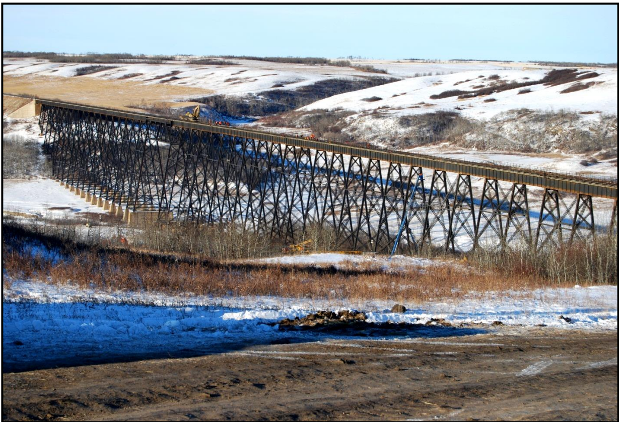
Photo 5. Pont de Fabyan, direction ouest
