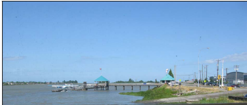
Photo 2. Photo prise au même endroit que la photo 1, mais par beau temps.
