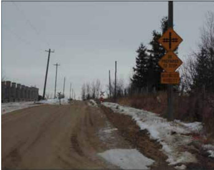
Figure 2. Panneau avancé d'avertissement à 100 m du passage à niveau (au sud de la voie, vue vers le nord)
