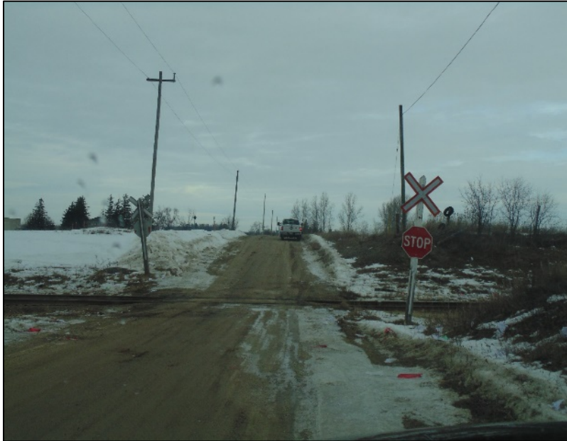
Figure 4. Panneau indicateur de passage à niveau standard avec panneau d'arrêt au passage à niveau (au sud de la voie, vue vers le nord)
