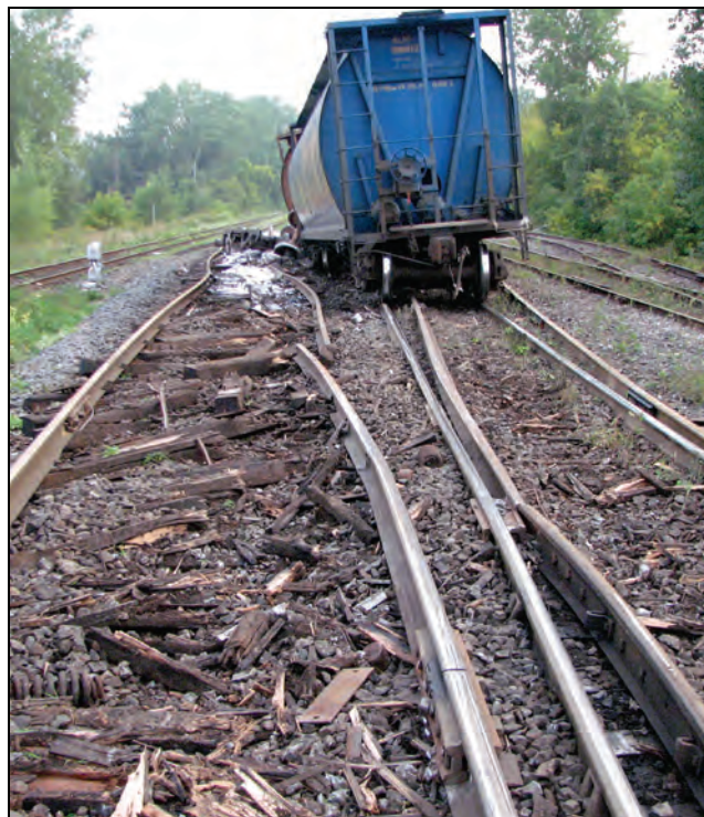
Photo 1. Dommages aux voies et aux branchements
